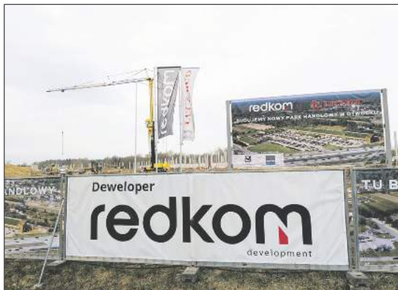
✚ Prace budowlane w parku są już zaawansowane
