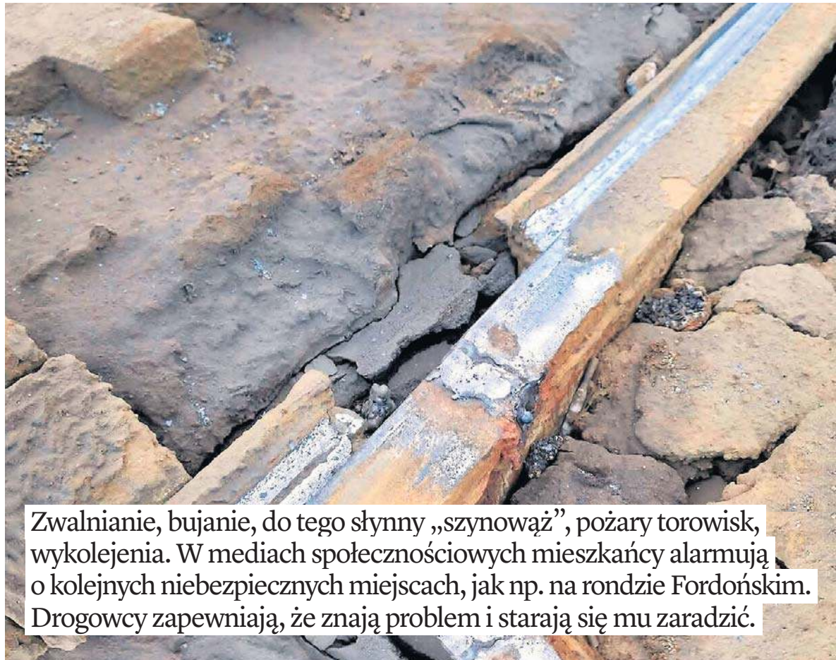
19 października 2025 r. pęknięcie szyny w ul. Focha
