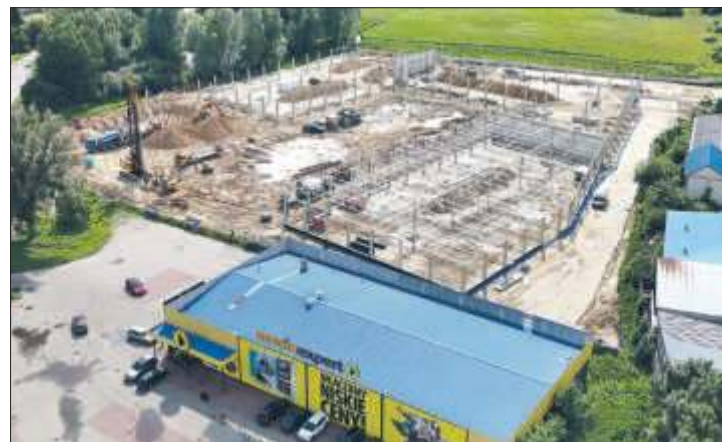
Nowa inwestycja przy ul. Sikorskiego 95 w Tomaszowie Lubelskim.
