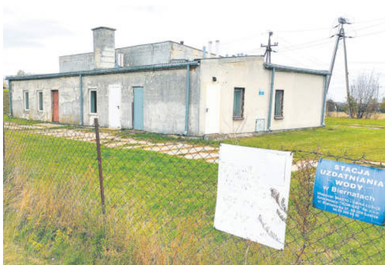
Stacja uzdatniania wody w Biernatach
