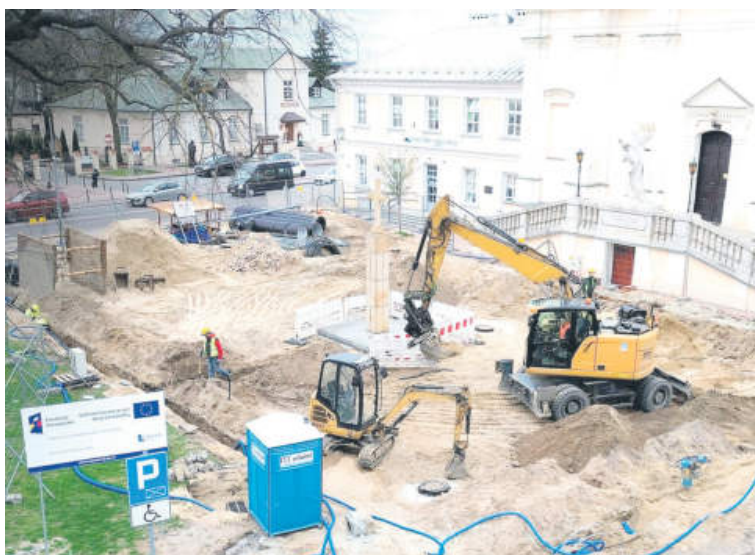
Prace na Placu Narutowicza. Zdjęcie z kwietnia fot. Urząd Miasta
