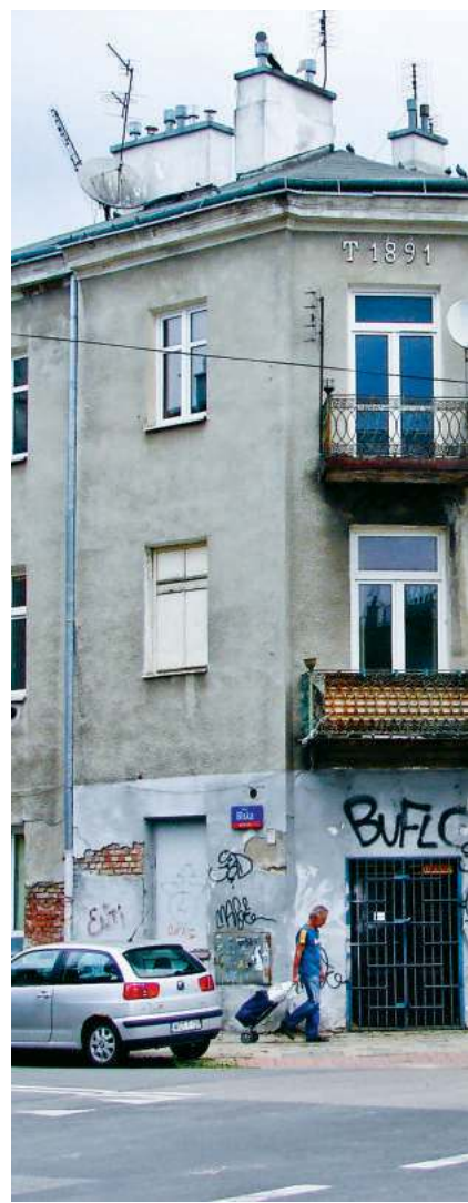
Kamienica Borensztedtów przy ul. Mińskiej 15 i frag
