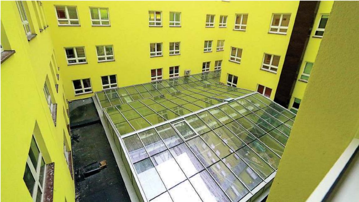
Trwająca od 12 lat rozbudowa COZL praktycznie została zakończona. Na początku kwietnia został oddany do użytku ostatni, trzeci budynek łóżkowy, który ma być wyposażony do końca czerwca. Do odbioru pozostają jeszcze tylko dwa modernizowane małe budynki radioterapii nr 13 i nr 15
