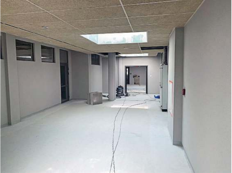
W szkole aktualnie trwają ostatnie prace wykończeniowe
