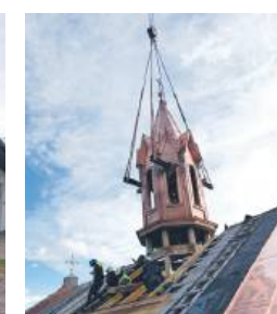
Remont wieżyczki kościoła
