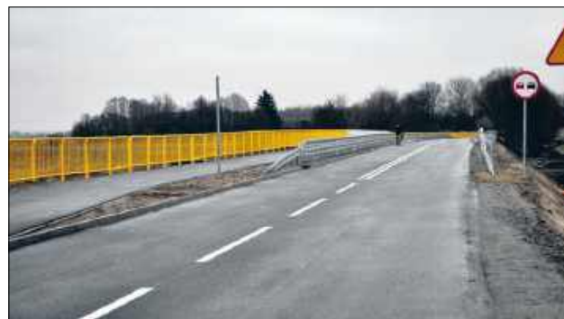
Poprzedni most został wyburzony, a nowy został wybudowany od samych fundamentów
