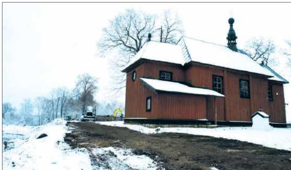
Obecnie kościół w Krzyczewie znajduje się 10 metrów od brzegu. Jest zagrożenie, że zostanie podmyty
