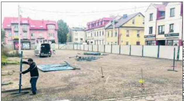
W ubiegłym roku właściciele działek na pl. Szkolny Dwór zagrodzili teren, ale na razie prac na nim nie prowadzą. Miasto związane ręce w kwestii komunikacyjnego uporządkowania tego obszaru
