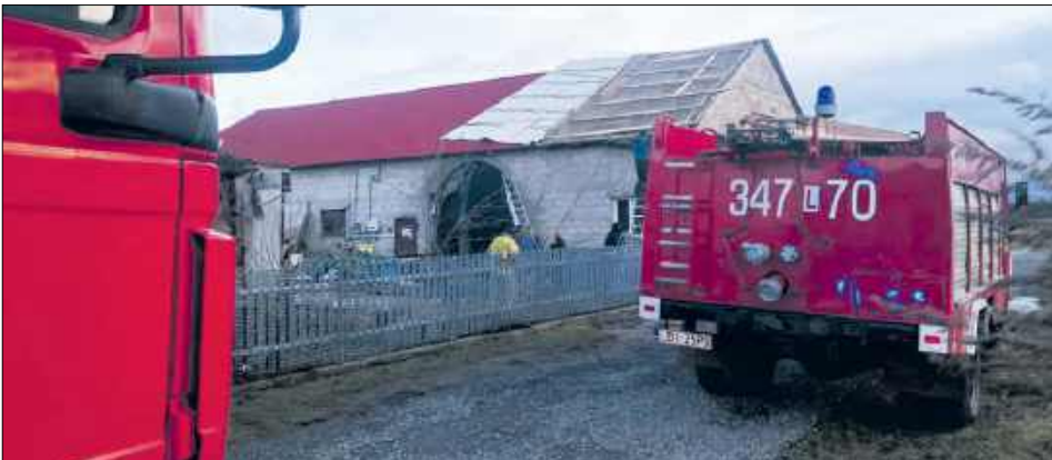
Dodatkowo strażacy byli dysponowani do zabezpieczenia zerwanych dachów budynków mieszkalnych oraz gospodarczych
