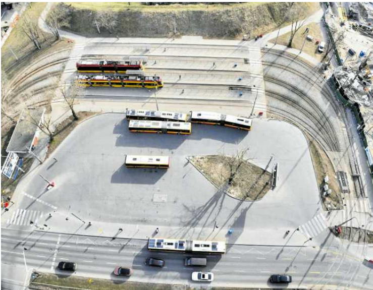
• Budowa stacji Lazurówka na drugiej linii metra (na zdjęciu z prawej) i pętla tramwajowa przy ul. Górczewskiej, pod którą będą drażone tunele w kierunku stacji Bemowo FOT. METRO WARSZAWSKIE
