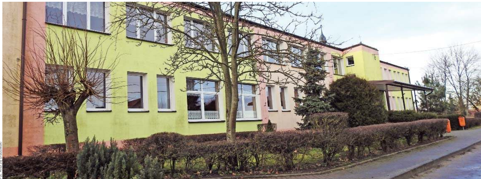
Po likwidacji szkoły w Grzędzie w jej budynku może powstać dom dla osób starszych i niepełnosprawnych
