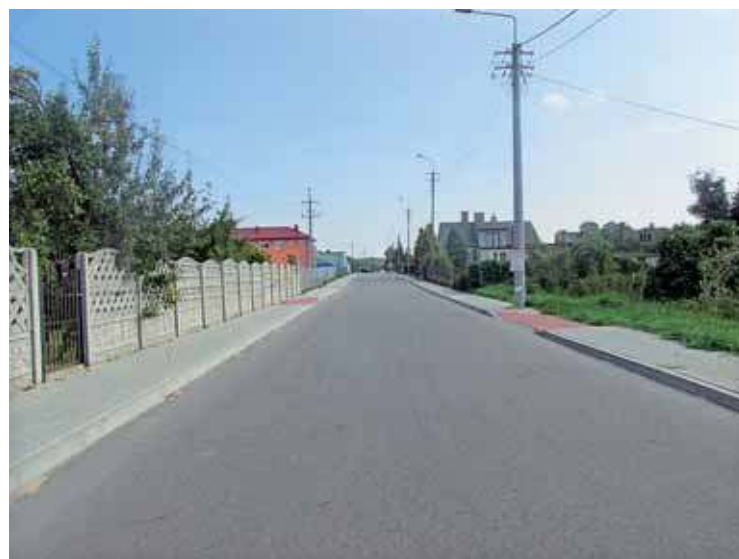
Gmina Leszno - Przebudowa targowiska gminnego „Mój Rynek” w Lesznie
