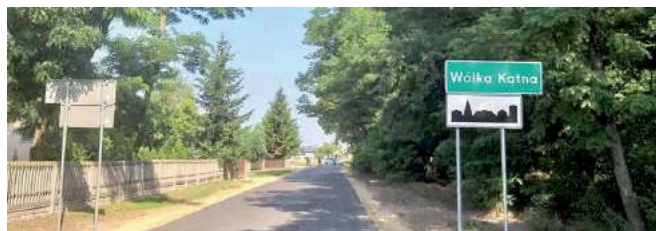
W ostatnim czasie gmina odebrała 1379 metrów wyremontowanego odcinka w Wólce Kątnej. Wartość projektu wyniosła 673 tys. zł, z czego ponad 420 tys. wyniosło dofinansowanie z PROW. Teraz samorząd szykuje się do kolejnych inwestycji drogowych
