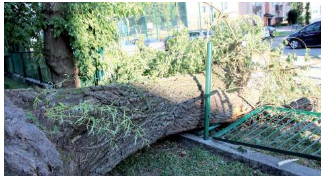
Ogrodzenie przy Przedszkolu nr 4 zniszczone przez padające drzewo
