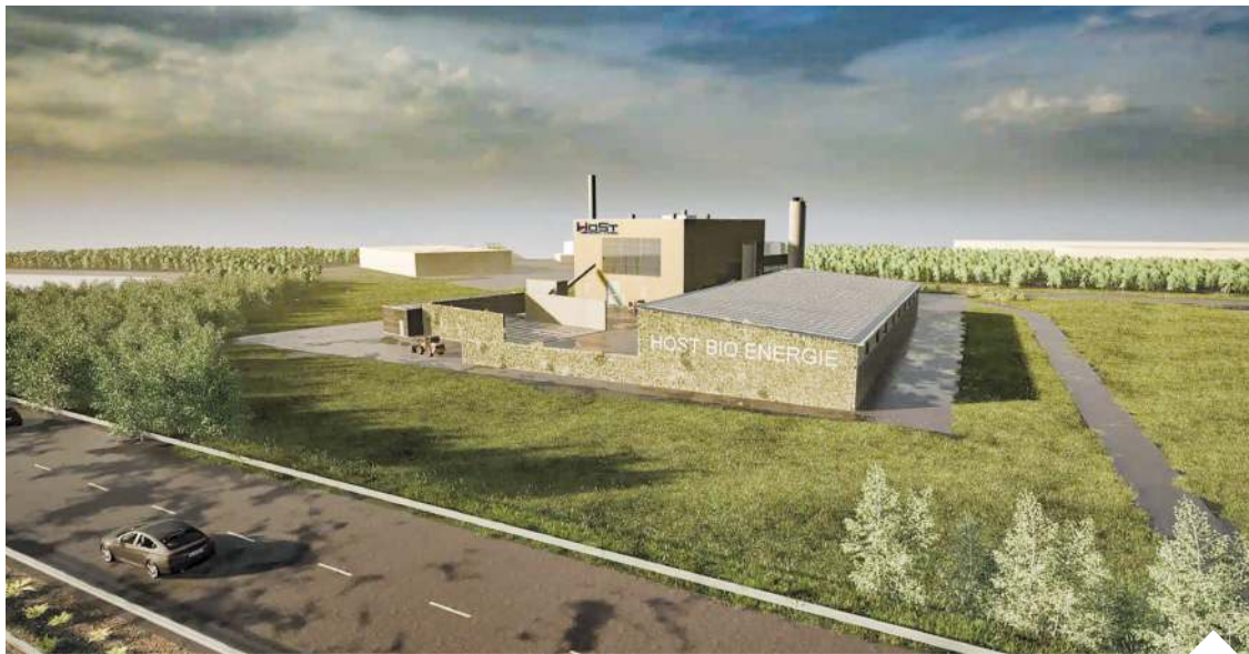
W Chemnitz w Saksonii rozpoczęła się budowa elektrociepłowni, która ma spalać około 100 tys. ton drewna rocznie | fot. mat. pras./d
