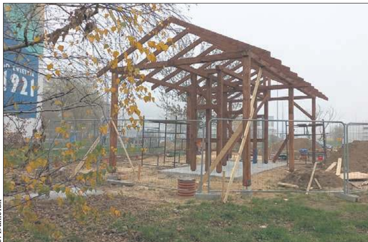
Jedna z tężni powstaje przy ul. Gierzyńskiego na Międzytorzu
