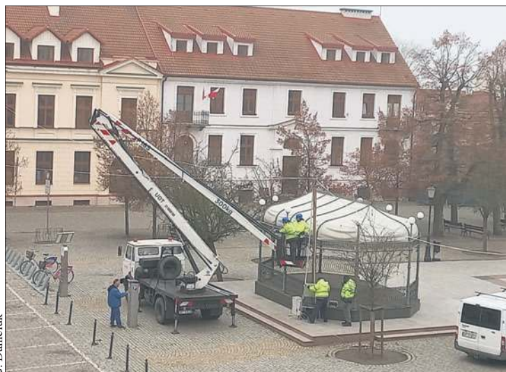
Na Starym Mieście trwa montaż świątecznych iluminacji
