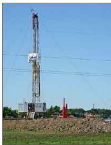
Prace wiertnicze w Pustkowie prowadzone były w 2020 roku.
