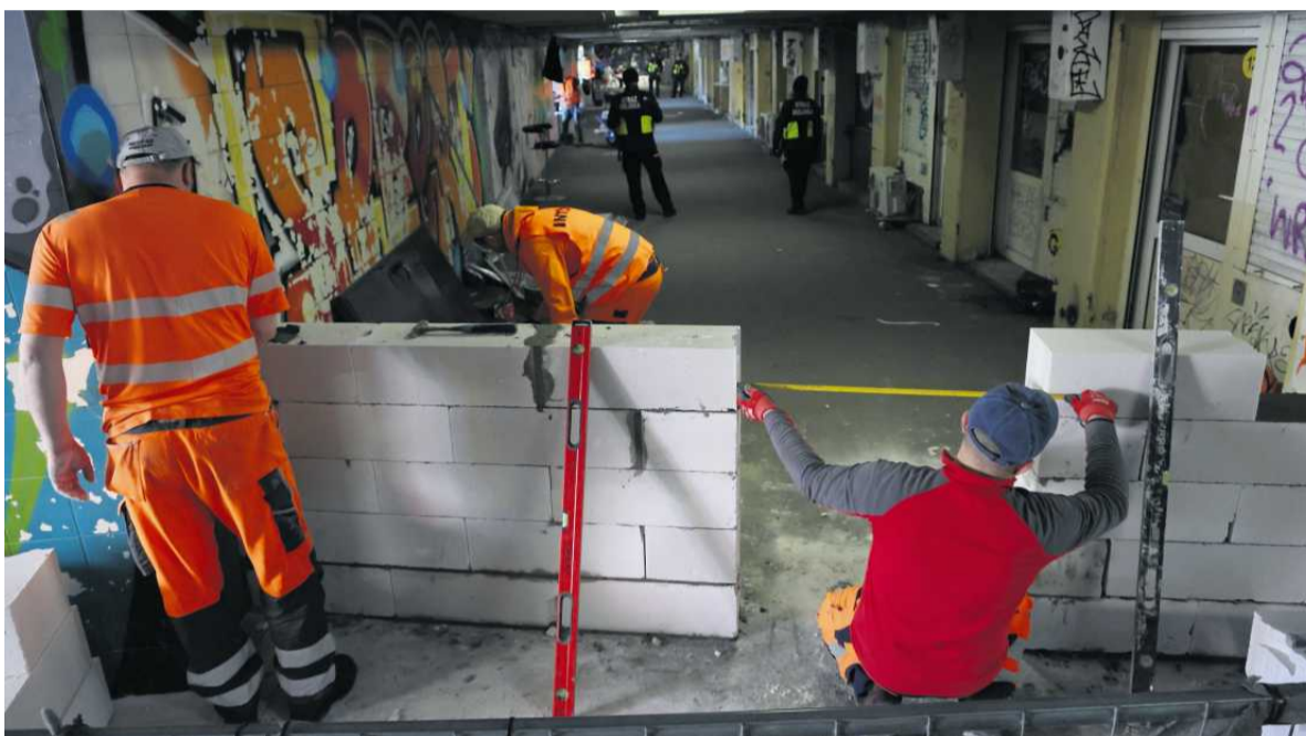
• Trwa zamurowywanie przejścia podziemnego na ul. Targowej FOT. ROBERT KOWALEWSKI / AGENCJA WYBORCZA.PL
