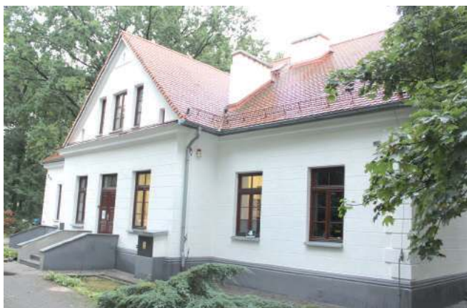
Prace remontowe przy Młodzieżowym Domu Kultury zmierzają ku końcowi. Budynek zostanie odebrany jeszcze w październiku
