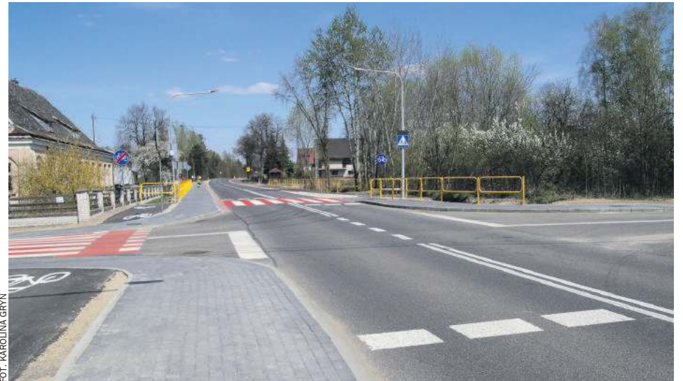
Dzięki przebudowie, wzmocnieniu i wykonanej infrastrukturze droga powiatowa nr 1069R powinna posłużyć podróżującym na lata
