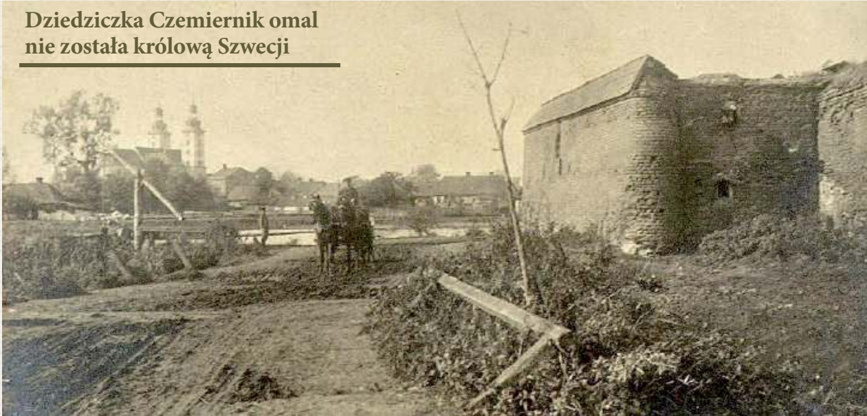
Z prawej strony mur fortalicji na początku XX wieku, w dalszym planie kościół św. Stanisława. Pierwszym działaniem Wincentego Krasińskiego po objęciu władzy w 1850 roku było wyremontowanie pałacu
