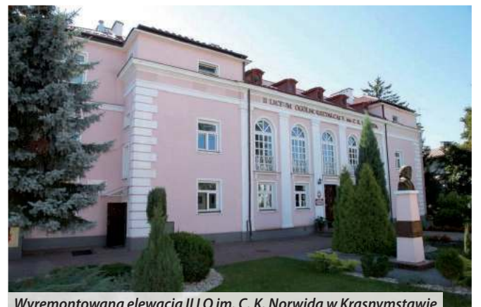
Wyremontowana elewacja II LO im. C. K. Norwida w Krasnymstawie
