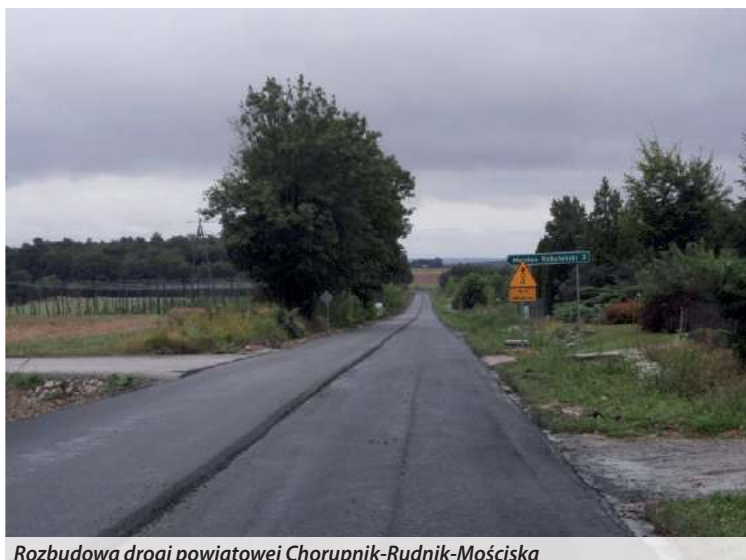
Rozbudowa drogi powiatowej Chorupnik-Rudnik-Mościska
