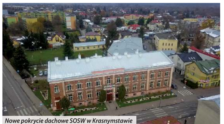
Nowe pokrycie dachowe SOSW w Krasnymstawie
