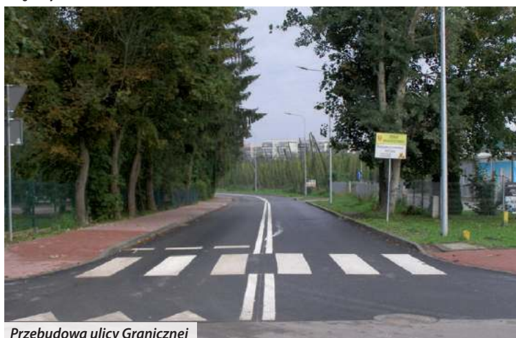
Przebudowa ulicy Granicznej
