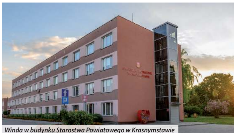
Winda w budynku Starostwa Powiatowego w Krasnymstawie
