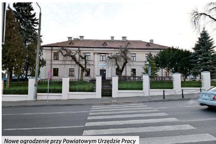
Nowe ogrodzenie przy Powiatowym Urzędzie Pracy
