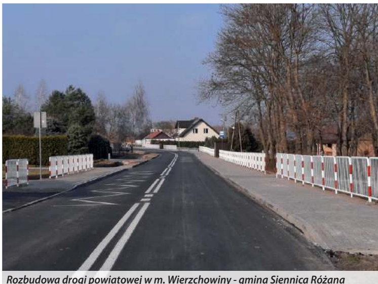
Rozbudowa drogi powiatowej w m. Wierzchowiny - gmina Siennica Różana
