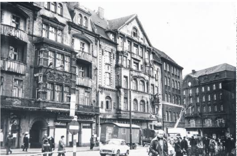
Plac Kościuszki tuż przed wyburzeniami. Demontaż detali z kamienia przeznaczonych na zagładę
