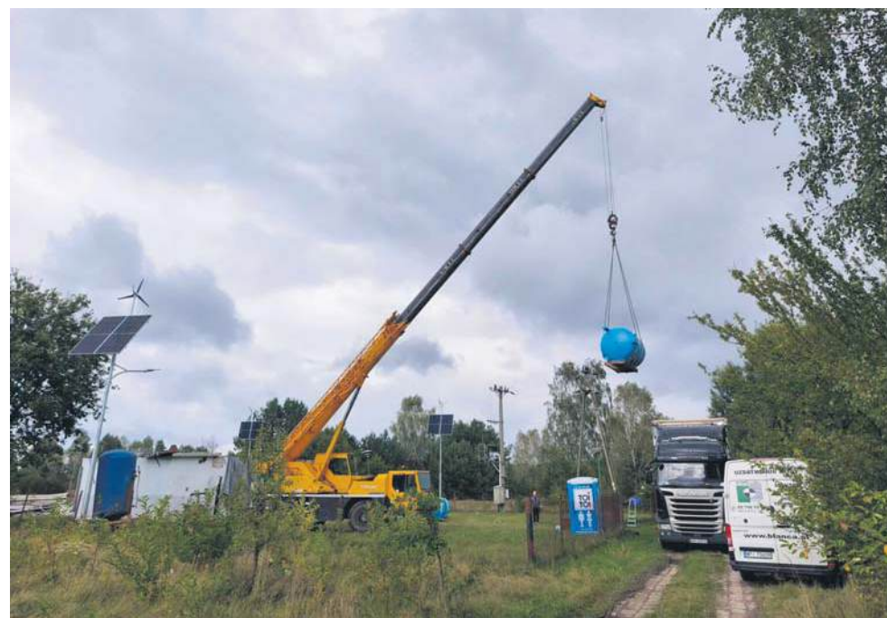
Rozładunek nowych urządzeń w Zbijowie Dużym
