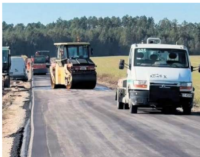
Przebudowa drogi w Płudnicy
