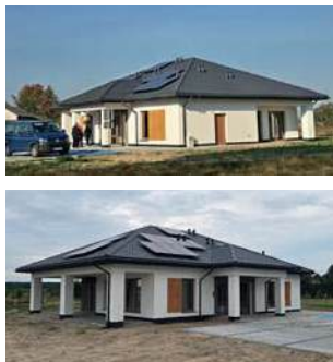
Nowe świetlice w Kamieniu i Zawadach
