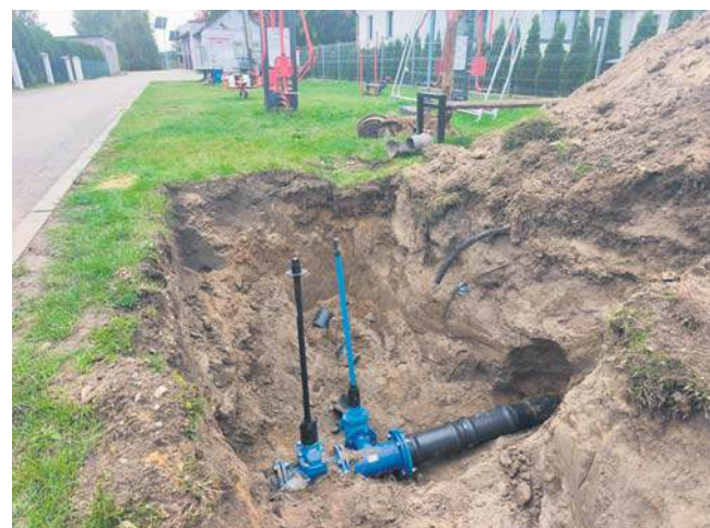
Prace przy wymianie zasuw
