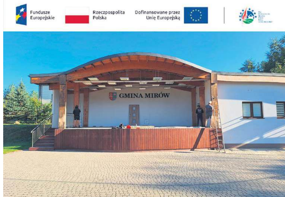
Prace remontowe przy budynku scenicznym w Mirowie
