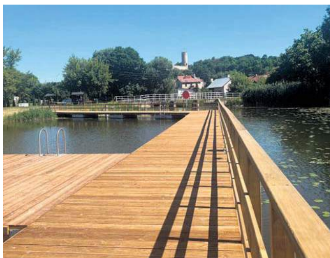
Nowo wybudowane moło na iłżeckiej przystani. W oddali baszta iłżeckiego zamku
