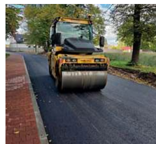
Przebudowa ulicy Szkolnej w Wieniawie
