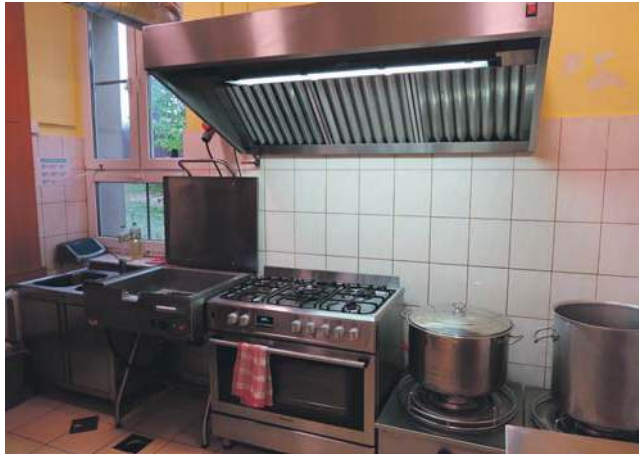
Zmodernizowane zaplecze kuchenne
