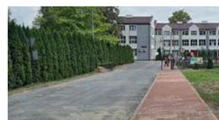
Budowa chodnika do szkoły wzdłuż ulicy Szkolnej
