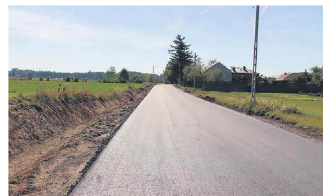
Fragment remontowanej drogi powiatowej 4518W w miejscowości Ostrownica w gminie Kazanów
