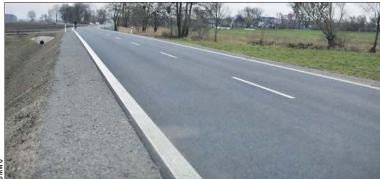
Odnowiony odcinek drogi
