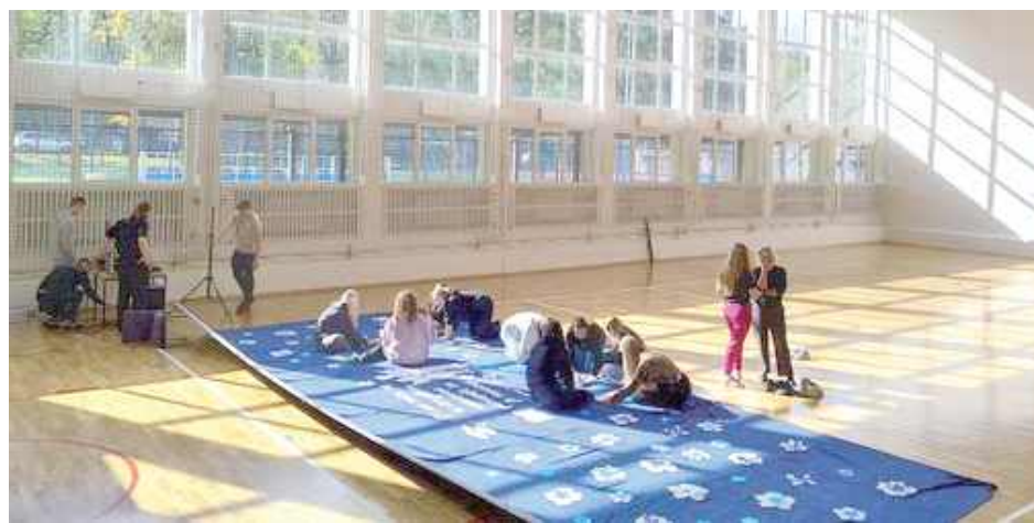
Gruntownej renowacji doczekała się m.in. podłoga w sali gimnastycznej Zespołu Szkół w Poniatowej
