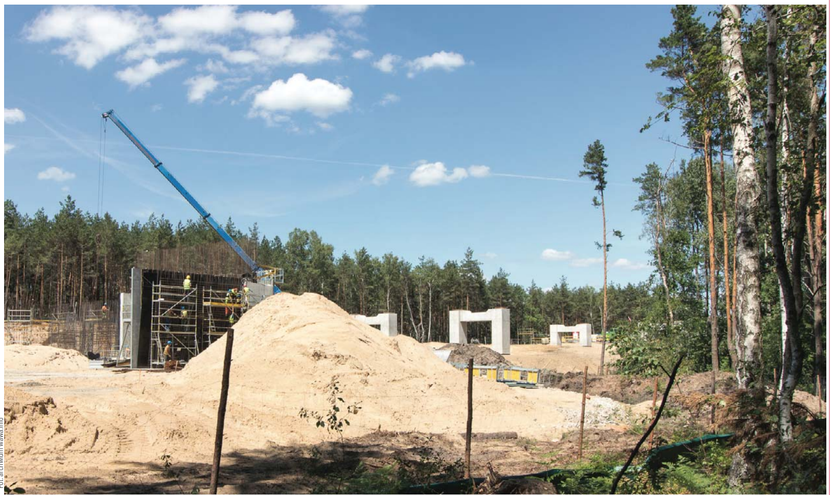
Zdjęcie ilustracyjne - Budowa estakady Południowej Obwodnicy Warszawy (POW) około 100 metrów od jeziora Torfy (lipiec 2018 r.)
