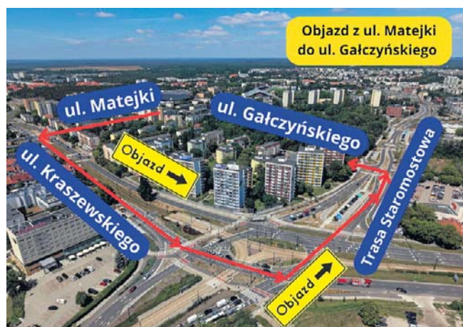
Rozpoczął się remont ul. Gałczyńskiego na odcinku od Trasy Staromostowej do ul. Matejki
