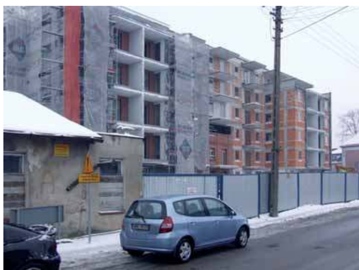
Przy skrzyżowaniu ulic Kościuszki i Lelewela powstaje blok z prawie 100 mieszkaniami
