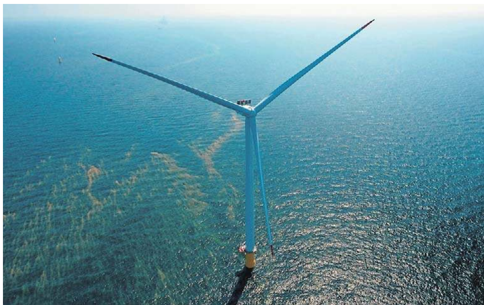
W2026 r roku popłynie prąd z farmy Baltic Power budowanej przez Orlen i Northland
