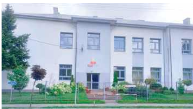
Część budynku szkoły podstawowej zostanie przystosowana na potrzeby utworzenia przedszkola. Następnie sale zostaną wyposażone w niezbędne sprzęty i przedmioty
