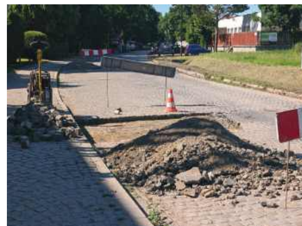
Trwa przekładanie granitowej kostki na ul. Długiej w Kondratowicach. Prace mają wyeliminować nierówności i uskok nawierzchni
