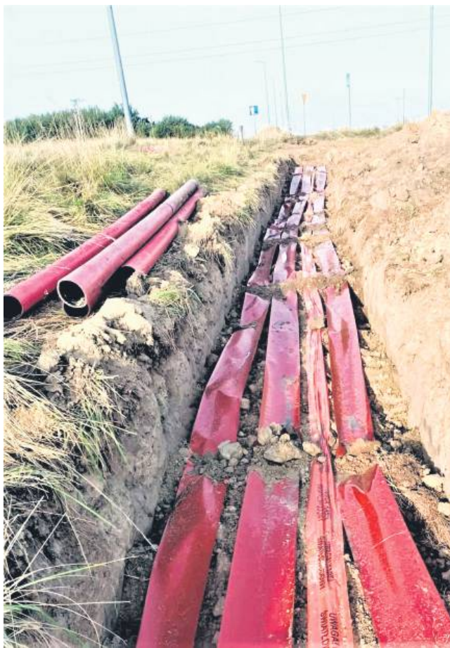
Modernizacja oraz budowa nowej infrastruktury elektroenergetycznej zapewni odbiorcom stabilne i bezprzerwowe dostawy energii elektrycznej.
