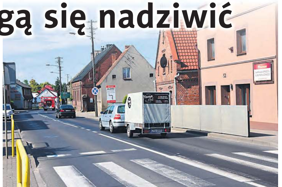
Ulica Nowodworskiego. Tutaj też trzeba było łączyć nawierzchnię.
