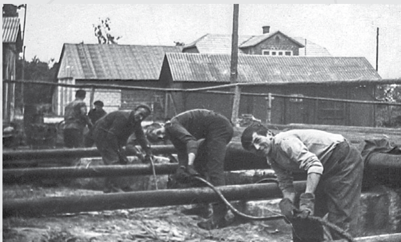
Budowa pierwszych gazociągów – Kopalnia Przemysł-Zachód
