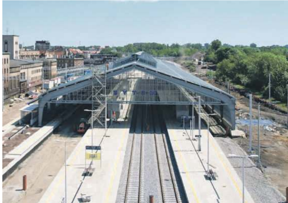
Ta hala naprawdę wygląda imponująco
