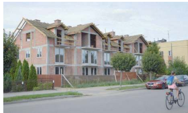
Wykonawca - Grupa PMM Sp. z o. o. z Lublina - ma czas na zakończenie prac do 17 grudnia br. Gmina Kock dostała na tę inwestycję 2,6 mln zł z rządowego Funduszu Inwestycji Lokalnych. Całkowita wartość inwestycji to niespełna 3,7 mln zł
