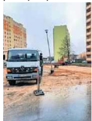
Plac przy Limanowskiego 80 wciąż jest rozkopany.
