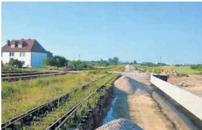
W Starej Woli Gołębiowskiej trwa już budowa przystanku kolejowego.
