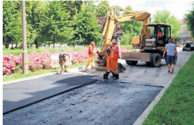
W poniedziałek na radomskich Plantach rozpoczęła się naprawa jezdni. Usunięto zniszczony asfalt i ułożono nowy.
