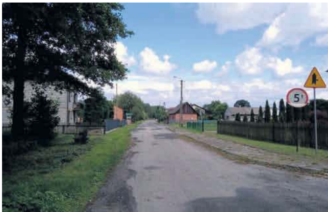
Prace przy remoncie drogi gminnej w Koszarach mają ruszyć lada dzień.
