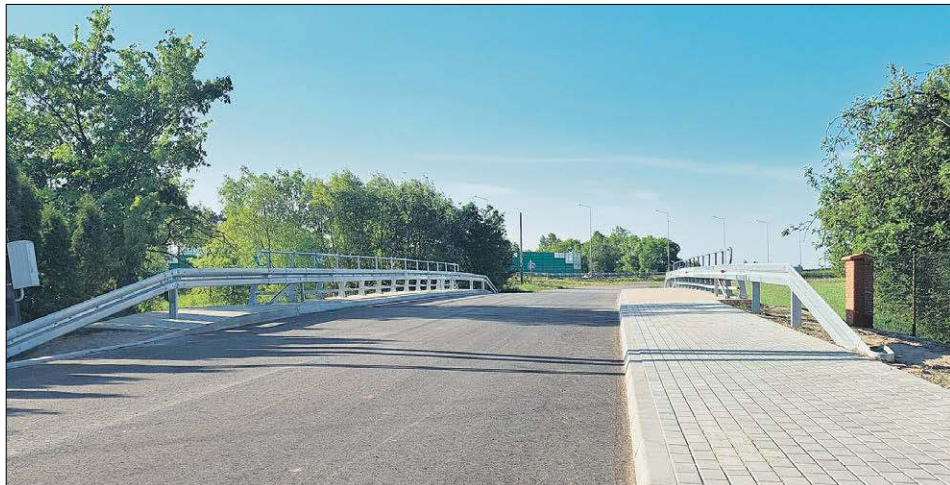
W Rzeczy został przebudowany most na rzece Krznie
