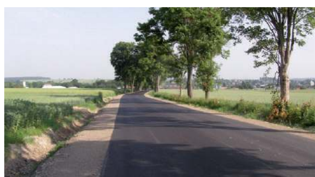
Przebudowa drogi powiatowej Średnia Wieś-Wierzchowina-Chłaniów-Bzowiec-Gruszka Mała
