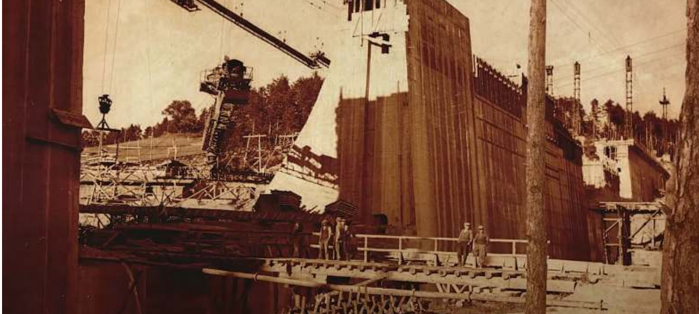
W ramach inwestycji w Centralnym Okręgu Przemysłowym ruszyła budowa trzech elektrowni – w Rożnowie (na zdjęciu), w Zakładach Azotowych w Mościcach oraz w Stalowej Woli
