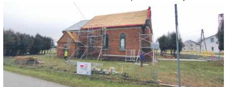
Wymiana dachu na kościele polskokatolickim w Gorzkowie-Osady
