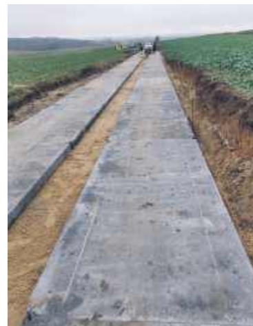
Budowa drogi w Czystej Dębinie
