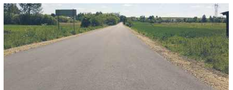
Remont drogi gminnej w Borowie-Kolonii
