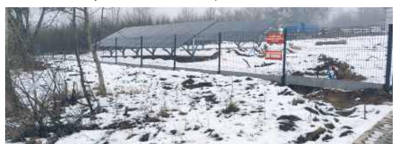
Roboty budowlane przy stacji ujęcia wody w Olesinie
