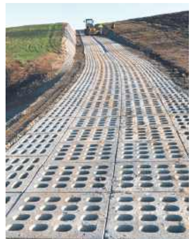
Budowa drogi w Wielkopole
