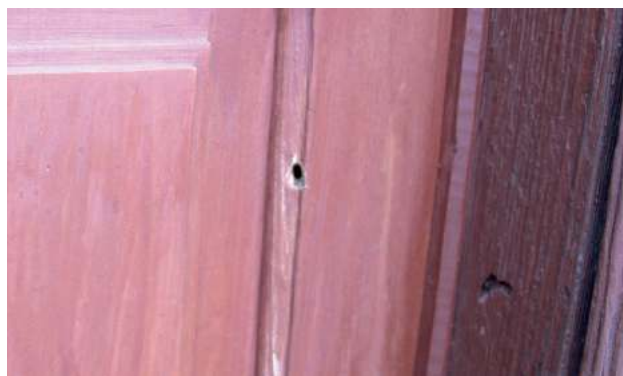
Otwór wlotowy po zewnętrznej stronie drzwi
