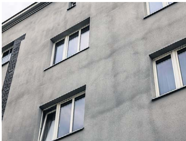
Zabytkowy budynek w trakcie renowacji. Ślady farby przebijają się spod tynku
