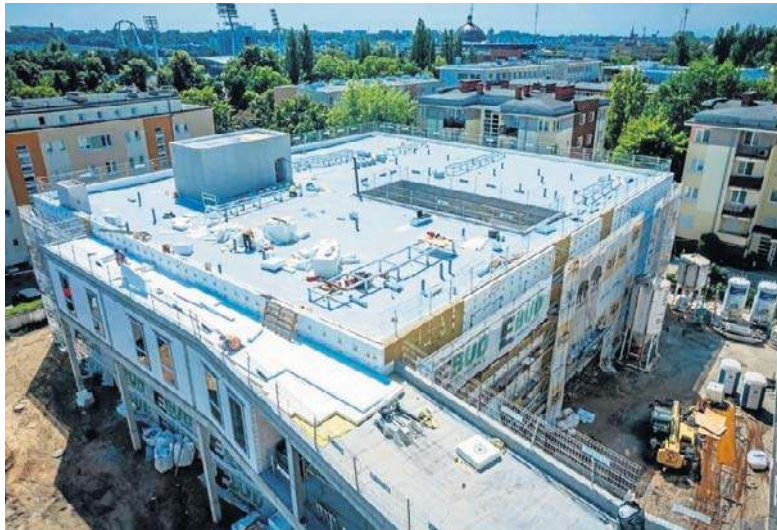
Budowa Ośrodka Diagnostyki Narządowej ruszyła w maju 2025 r.
