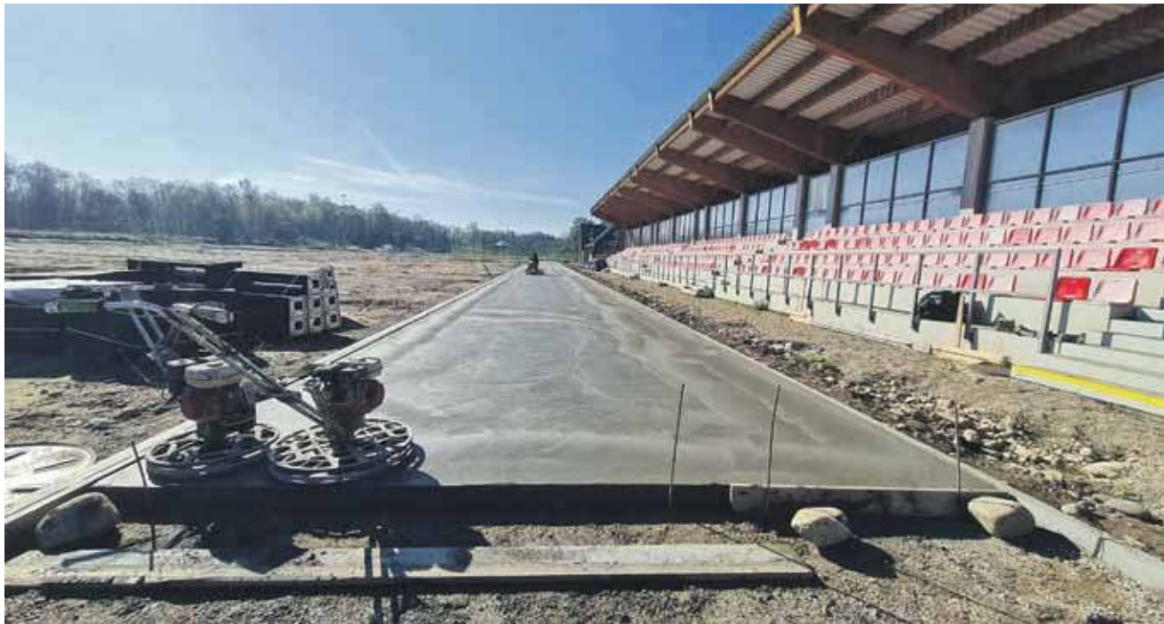
W zeszłym tygodniu 400-metrowe bieżnię zostały wybetonowane, by można było położyć na nie tartan.
