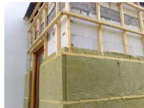
🔦 W metodzie lekkiej suchej zastosowanie ma tylko wełna mineralna. Wypełnia się nią drewniany lub stalowy ruszt konstrukcyjny przymocowany do ściany, a następnie osłania ocieplenie wiatroizolacją i okładziną elewacyjną. EKODREWNO
