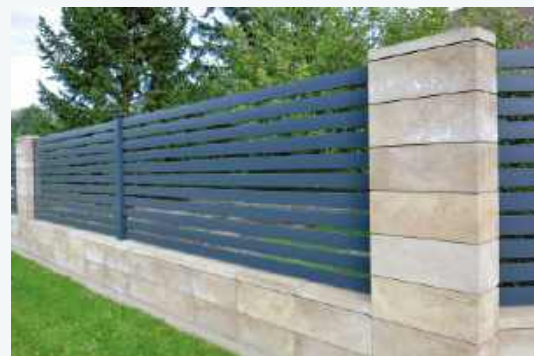
Trwałe ogrodzenie postawiono z gotowych kształtek z betonu oraz stalowych przęseł.
