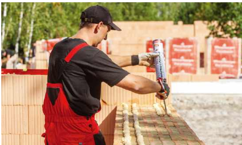
🔑 Ceramika poryzowana ma znacznie lepsze parametry cieplne od zwykłej. Ponadto jest od niej lżejsza, co ułatwia murowanie. wienerberger
