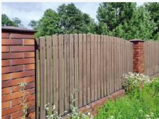
Frontowe ogrodzenie wykonano z klinkieru i drewna.
