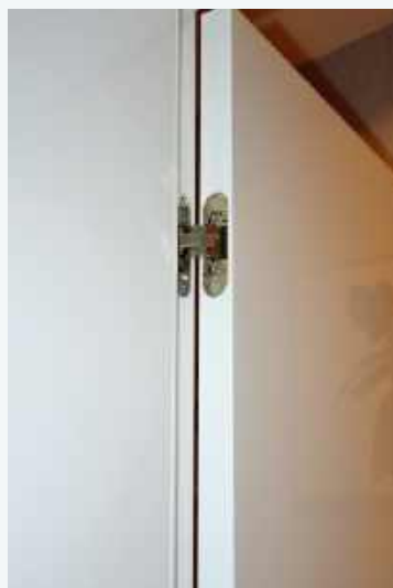
Ruchome elementy drzwi zawieszono na solidnych zawiasach. Na ościeżnicy przytwierdzono uszczelkę
