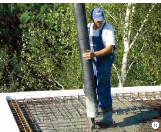
🔗 Układanie zbrojenia (a) i zalewanie mieszanką betonową stropu monolitycznego (b). T. RYBARCZYK
