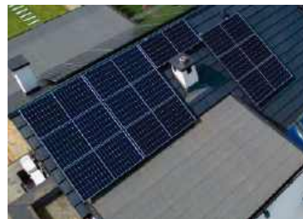
Montaż paneli fotowoltaicznych najlepiej przewidzieć już podczas projektowania dachu. RÖBEN
