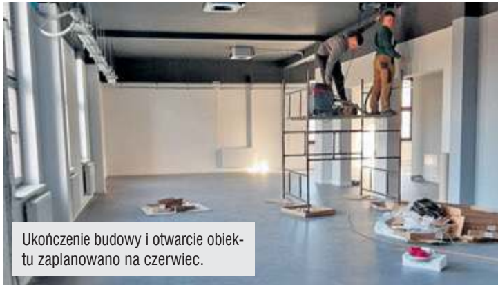
Prace prowadzone są również na zewnątrz budynku.
