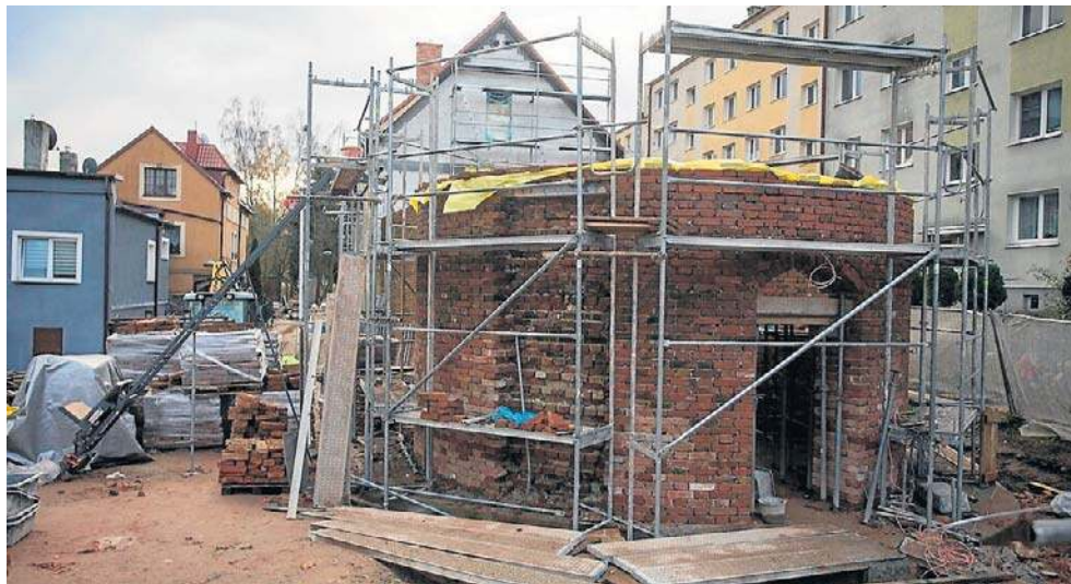
W rekonstruowanej baszcie znajdzie się niewielka przestrzeń umożliwiająca np. organizowanie wystaw. Zwieńczy ją stożkowy dach kryty ceramiczną dachówką
