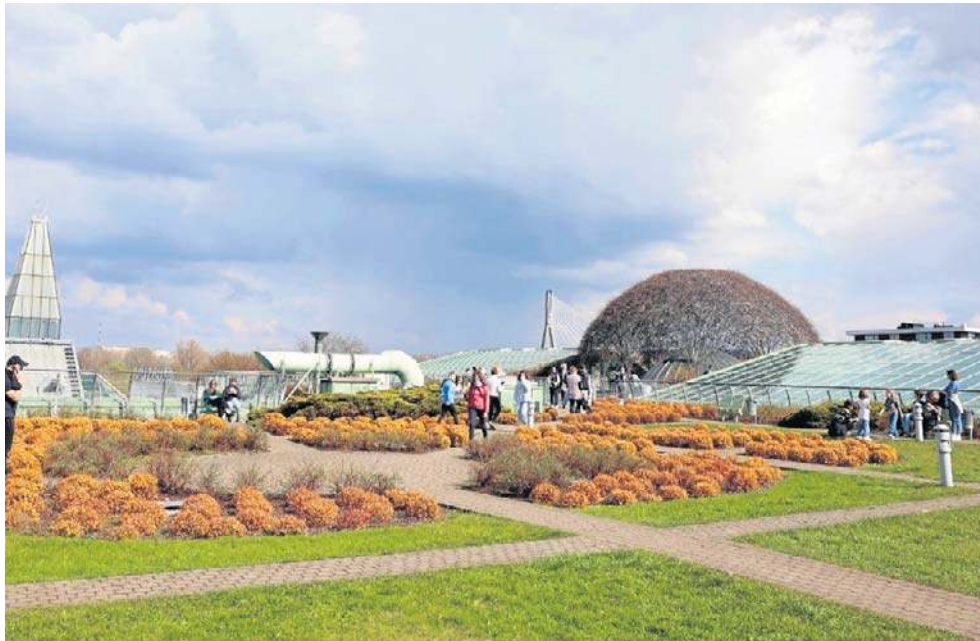
Biblioteka Uniwersytetu Warszawskiego - to prawdziwy ogród na dachu i jedno z pierwszych oraz najbardziej spektakularnych założeń w Polsce.
