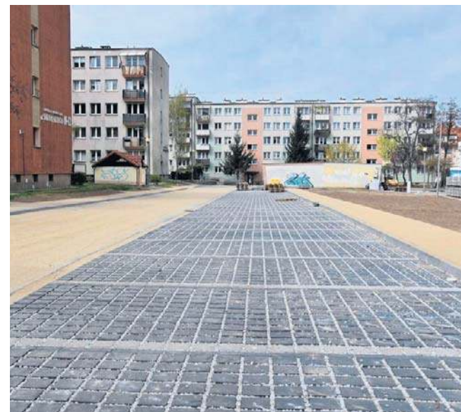
Mieszkańcy osiedla widzą szybkie postępy inwestycji
