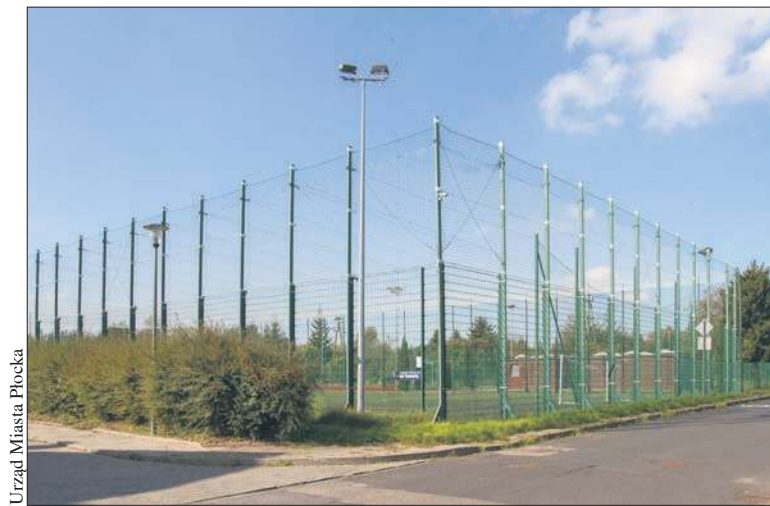
Czas na remont Orlika przy ul. Zamenhofs na Winiarach
